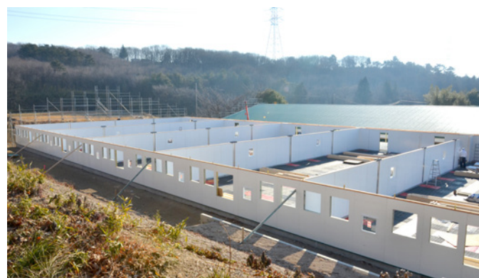
パネル豚舎施工風景
