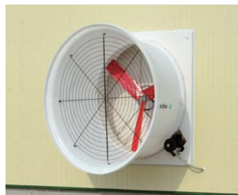
50 インチファン ベルトドライブ方式
